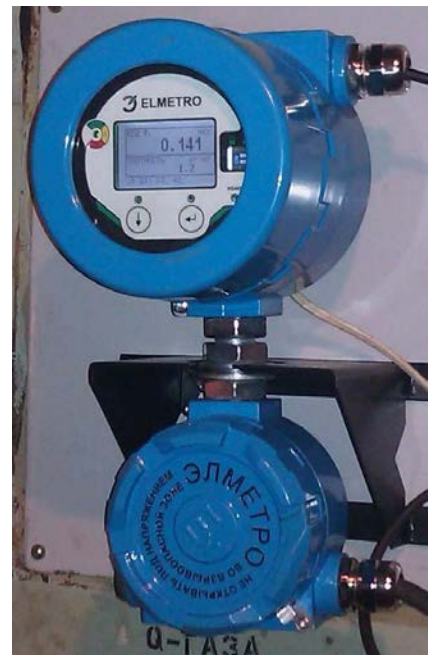
Модуль процессора на кронштейне
